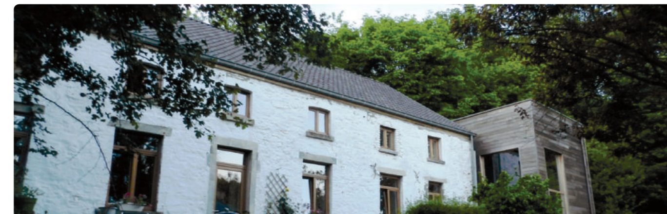
Le volume secondaire se distingue clairement par rapport au volume principal, tout en respectant son architecture (volume simple) et la hiérarchie des volumes. L'utilisation d'un bardage en bois grisonnant est en harmonie avec la cadre de vie. Par contre, au sein du parc naturel, la toiture plate ne peut être appliquée que si une dérogation au RGSBR est accordée. Un éventuel regret, d'un point de vue paysager, est la hauteur du toit du volume secondaire plus haute que celle de la gouttière du volume principal.
