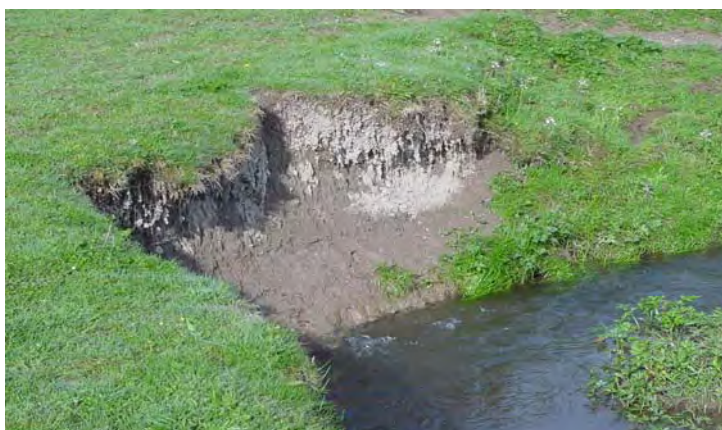
Anse d'érosion le long d'un cours d'eau
