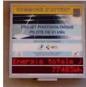
suivantes en temps réel : ensoleillement (Watts/m<sup>2</sup>), température des panneaux (°C), puissance électrique des panneaux (Watts), énergie électrique totale produite le jour en cours (Wh), énergie électrique
